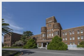
旧九州帝国大学 工学部本館
